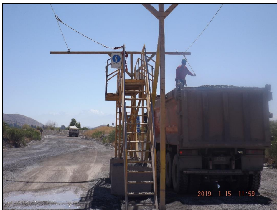
Foto N°4. Registro Fotográfico de Instalación de Encarpado de Tolva de Camiones para el Ingreso como para la Salida de la Planta
